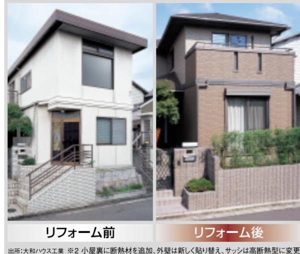
出所:大和ハウス工業 ※2 小屋裏に断熱材を追加、外壁は新しく貼り替え、サッシは高断熱型に変更
