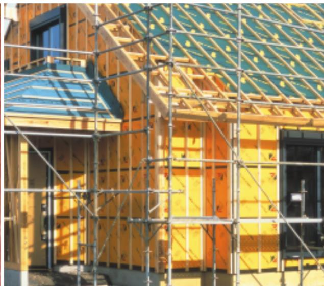
(外張断熱工法例)写真提供:アキレス
