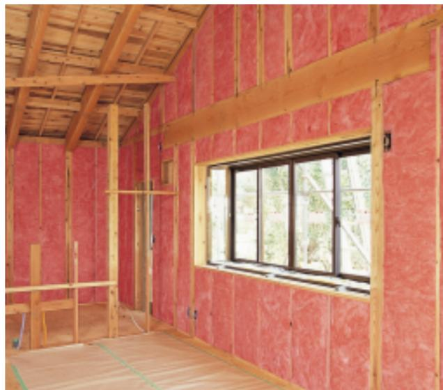
(充填断熱工法例)写真提供:マブ
