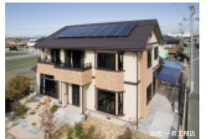
写4 屋根置き型太陽光発電システム
