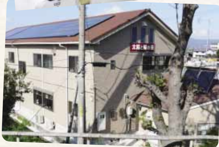
屋根には太陽光発電パネル(左)と太陽熱温水器(右)を設置。電気とお湯の多くをまかなっている。
