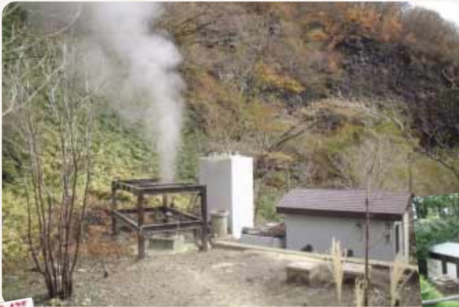
奥がヒートポンプ設備、手前がボイラー設備。 ボイラー設備も補助設備として残している。
