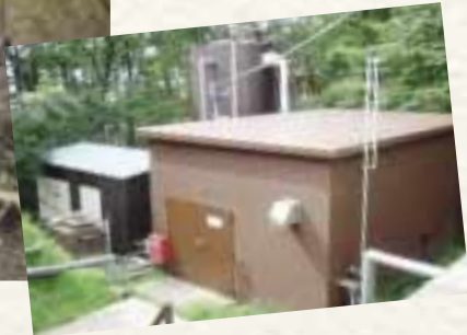
奥がヒートポンプ設備、手前がボイラー設備。 ボイラー設備も補助設備として残している。
