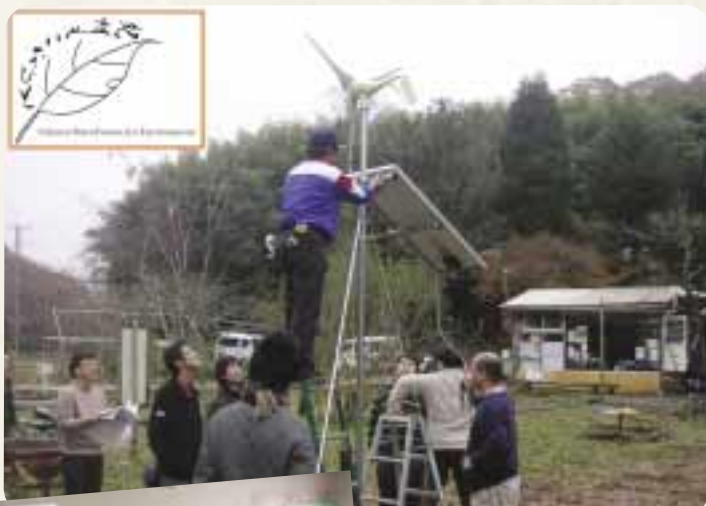
市民共同発電の設置作業。 資金集めから組立まで、全て 市民の手で行われている。
