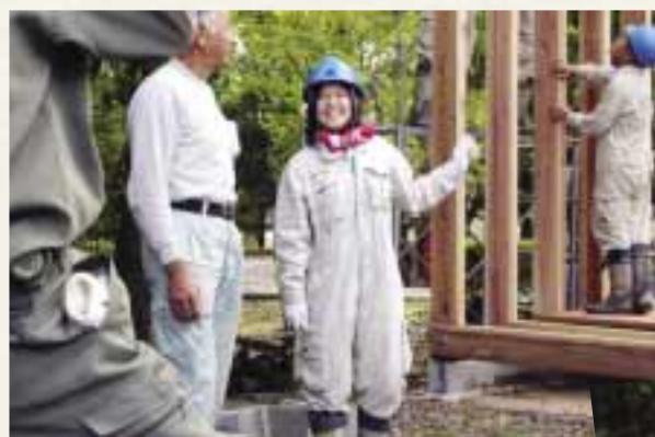
京都大学が開発した、間伐材を有効利用する工法「J-podシステム」を採用。
